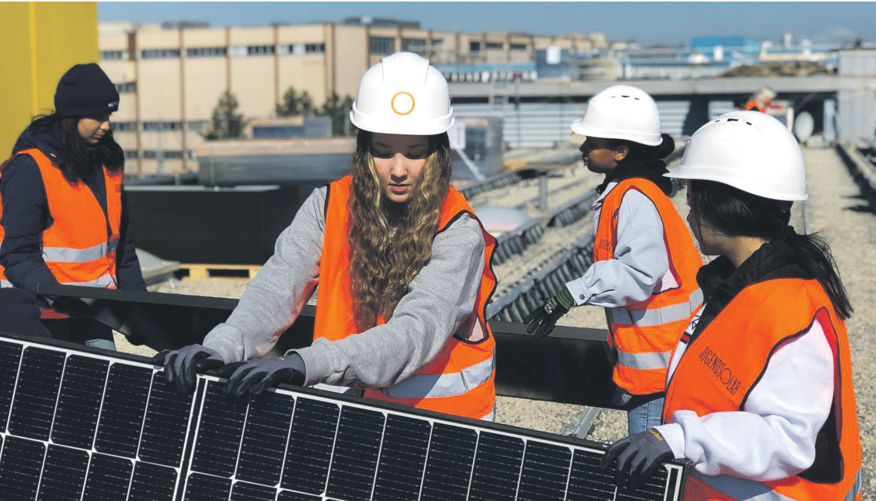
Jugendliche installieren im Rahmen der Projektwoche Jugendsolar eine Solaranlage.
